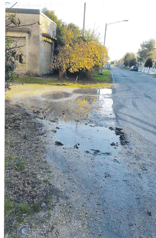
Via Stradone - Marmorta
